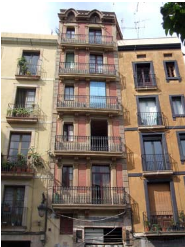
Façana de l'edifici en rehabilitació.
