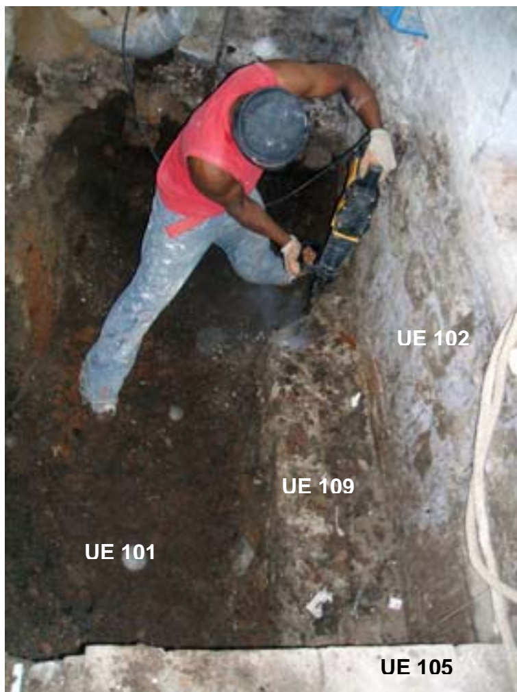
Procés de desmuntatge del mur (U. E. 109) mitjançant martell elèctric.
