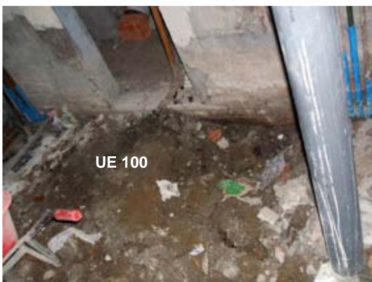
Fase inicial del rebaix de la superfície afectada (U. E. 100).
