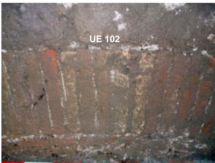
Detall de l'arc de descàrrega present en la U. E. 102.
