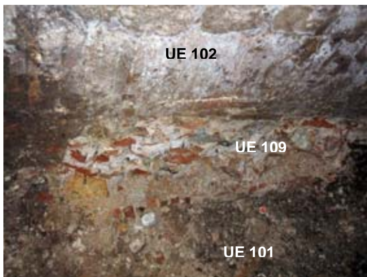
Mur (U. E. 109) retallat per a instal·lar la caixa de l'ascensor.
